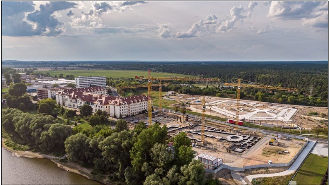
Fot. 1 Teren budowy w zachodniej części Torunia (źródło: wiadomości.onet)
